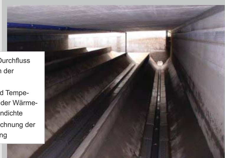
Wärmeüberträger in Regenbecken mit Drachenprofil
