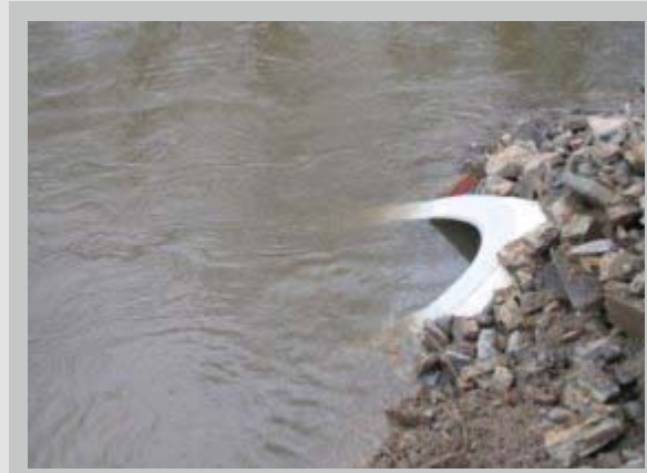
Mündung des Entlastungskanal in den Vorfluter (bei Hochwasser)
