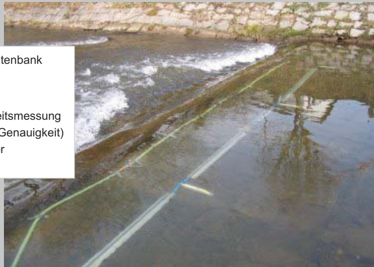
Sensormontage auf Gewässersohle
