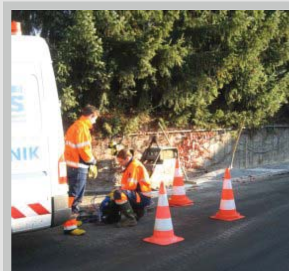
Einbau der Messtechnik
