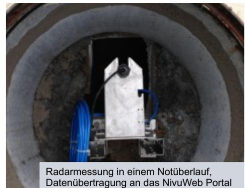
Radarmessung in einem Notüberlauf,
