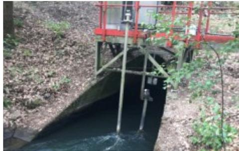
Radarmessung im Ovalen Profil, Installation ohne Prozessunterbrechung, keine Stromversorgung
