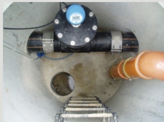
Messstellenansicht im Schacht
