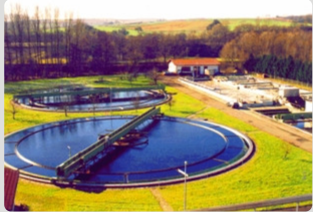
Nachklärbecken mit Räumbrücke
