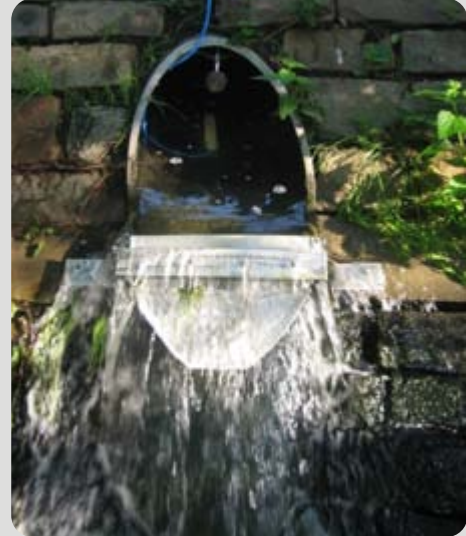
Auslaufrohr mit Aufstaublech
