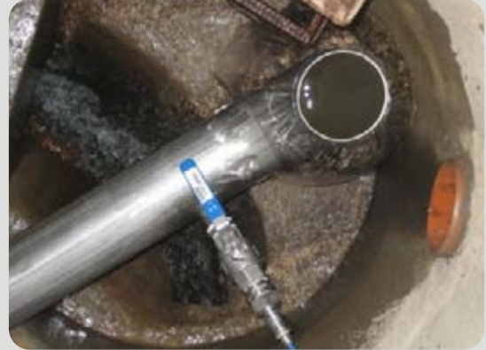
Installierte Messung im Kontrollschacht
